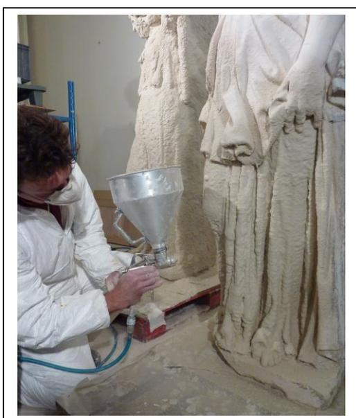
*Dessalement par compresses appliquées par projection d'un mélange à base d'argile sur une statue.*
